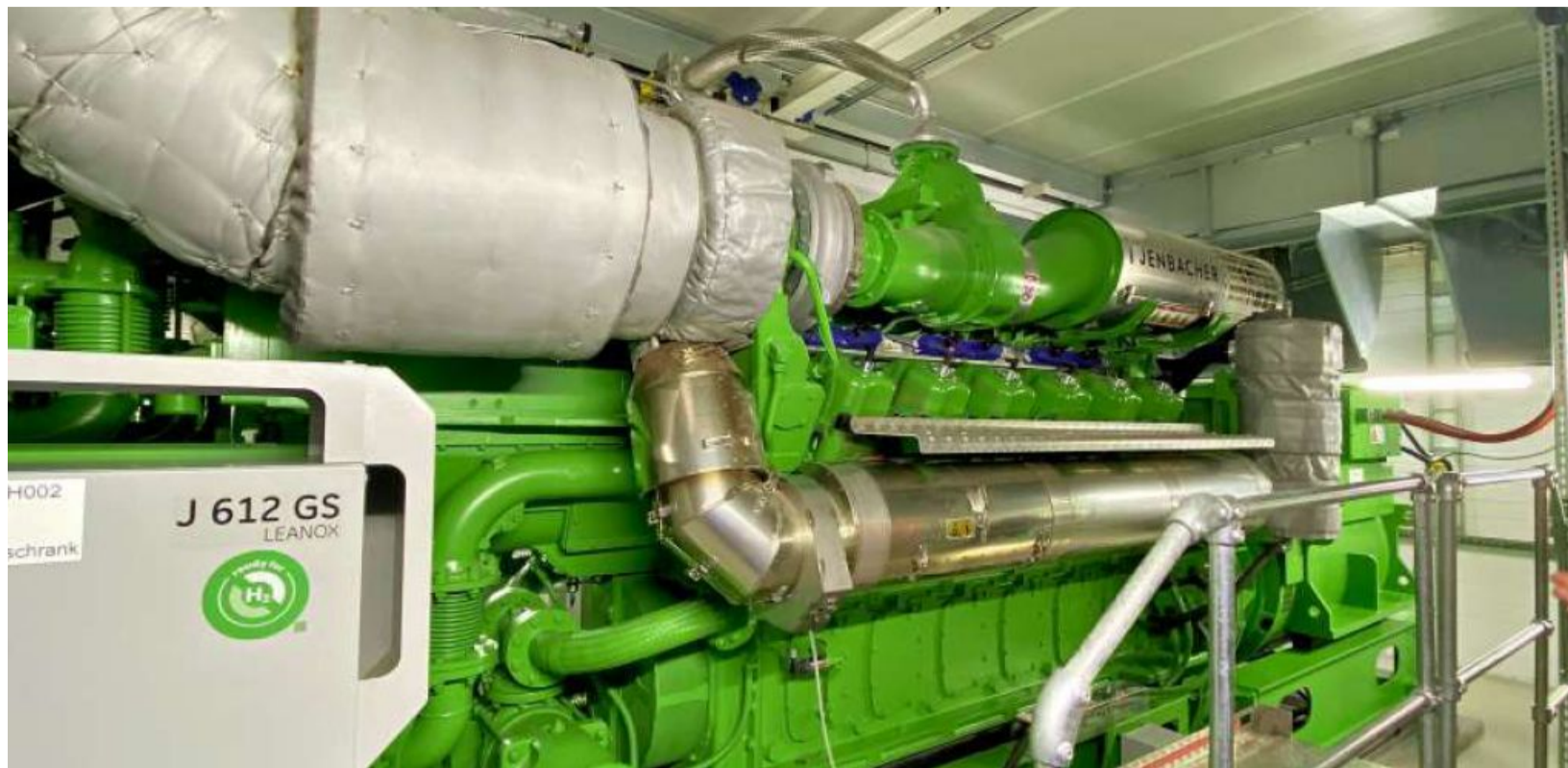
Einer der Motoren, die nun im modernisierten Blockheizkraftwerk in Schönebeck in Betrieb sind.
