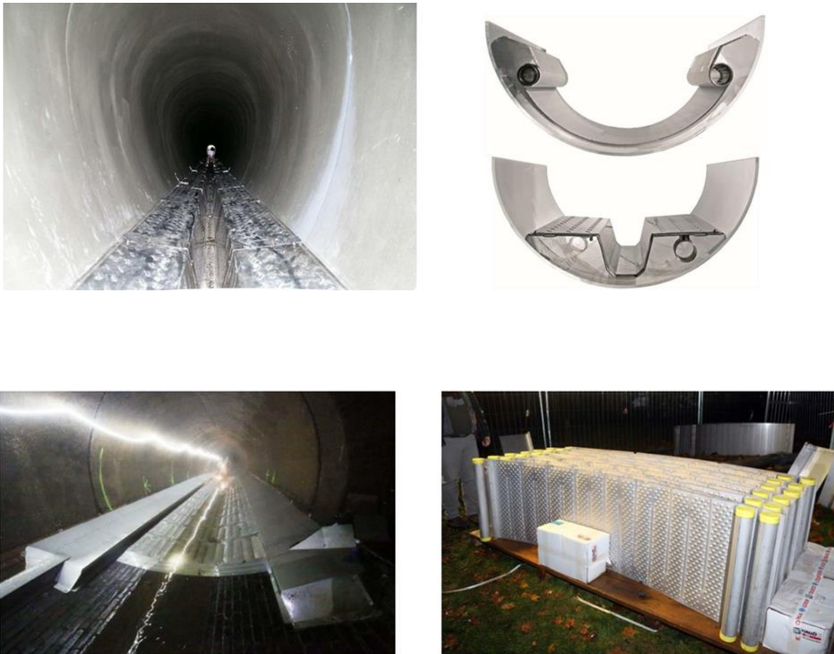
Abbildung 65: Abwasserwärmetauscher. Bildquelle: Uhrig (20) (oben), STAWAG (21) (unten)
